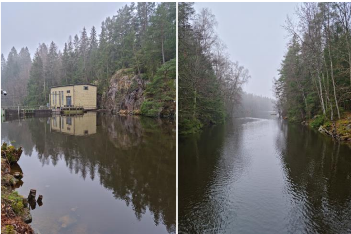
Figur 7: Till vänster: Solvedens vattenkraftverk. Till höger: Mjörns utlopp till Sävån uppströms Solveden.
